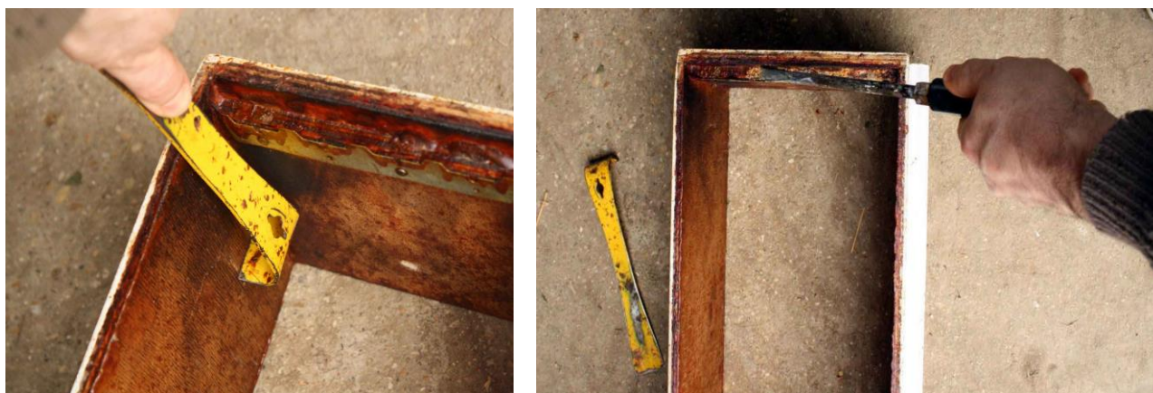
Grattage du matériel , première étape indispensable avant désinfection
